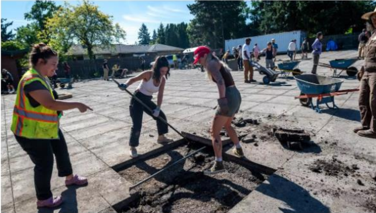
Vecinos de Portland levantan cemento en la iglesia Morning Star de Portland el verano de 2023. Depave
